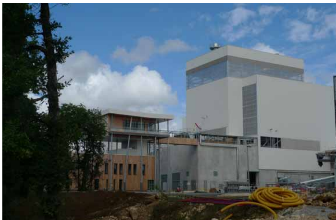
La fin des travaux est proche pour le centre multifilières qui aurait dû fonctionner à partir du mois d'octobre. Au mieux, il ne pourra pas fonctionner avant plusieurs semaines. PHOTO D. B.
